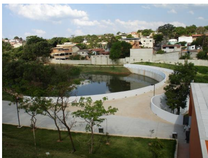
Figura 1 - Reservatório de retenção
